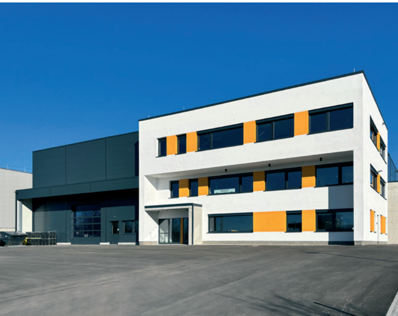
Abler Coating Kempten - Produktionshalle mit Verwaltung (schlüsselfertig)
