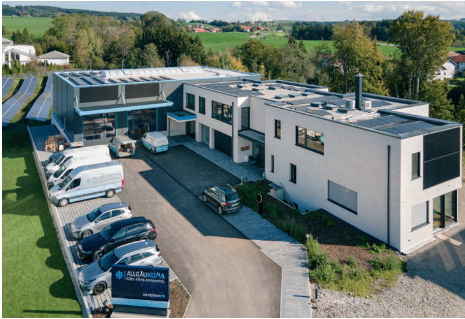
Allgäu Klima Wildpoldsried - Wohnhaus, Büro & Gewerbehalle (Rohbau)
