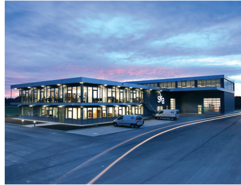
SKA Illertissen – Neubau Verwaltung & Montagehalle (Rohbau)
