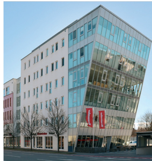
Ärztehaus „Cambomed“ Kempten (Rohbau)
