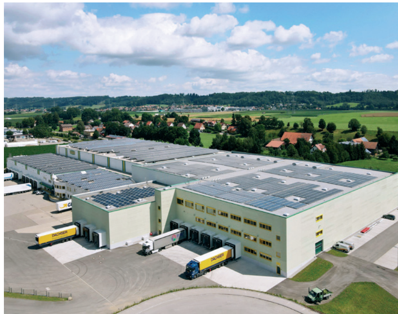
Rapunzel Logistikzentrum Bad Grönenbach – Süderweiterung (schlüsselfertig)
